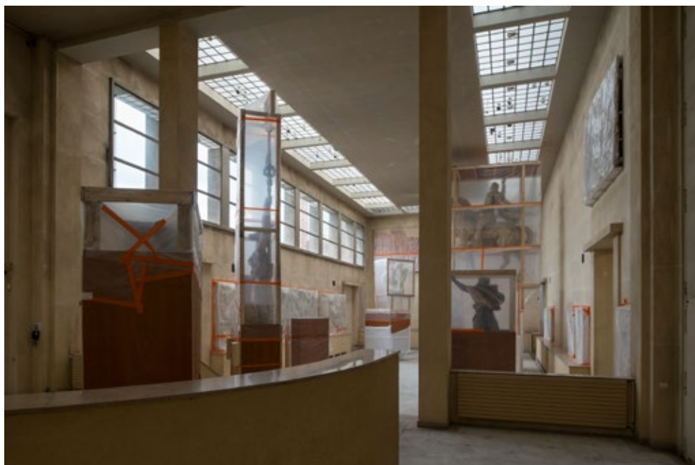
Le hall des plâtres avant le début des opérations de nettoyage
