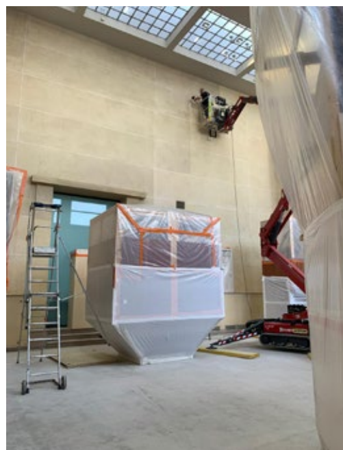
Opération de nettoyage au laser embarqué dans une nacelle
