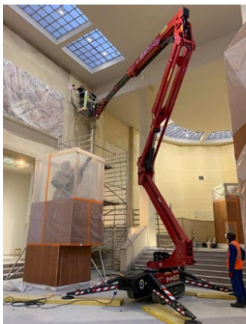
Opération de nettoyage au laser embarqué dans une nacelle
