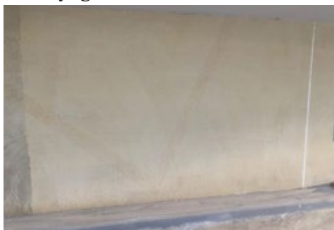
Nettoyage au laser - après
